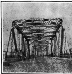
CACOCÓN. —He aquí una de las más grandes obras de la Carretera Central; el puente sobre el Caño entre Bayamo y Holguín. (Foto Cruz y Trinchet).
